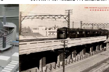
大阪市内高架線 T15 乗客の増加に対応するため、神戸線を宝塚線から、分離、複線高架化された。
